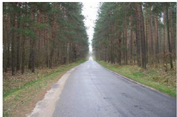
Fot.37. Po nałożeniu asfaltu
