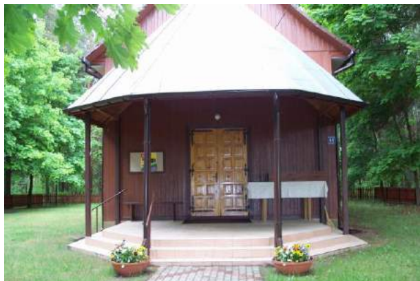
Fot.311. Zadaszenie nad wejściem do kaplicy ufundowane przez Dorotę Zych - Gałczyńską
