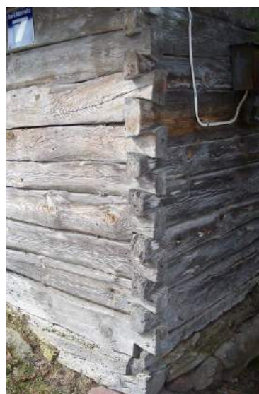
Fot.141. Węgła robiono na zakładkę
