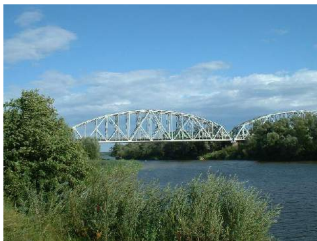
Fot.183. Most kolejowy we Fronołowie
