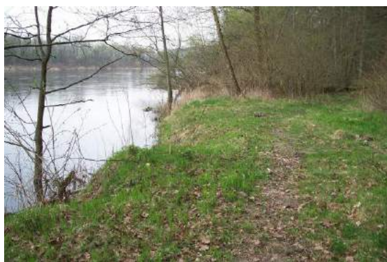
Fot.64. Rzut oka na bindugę od strony lądu
