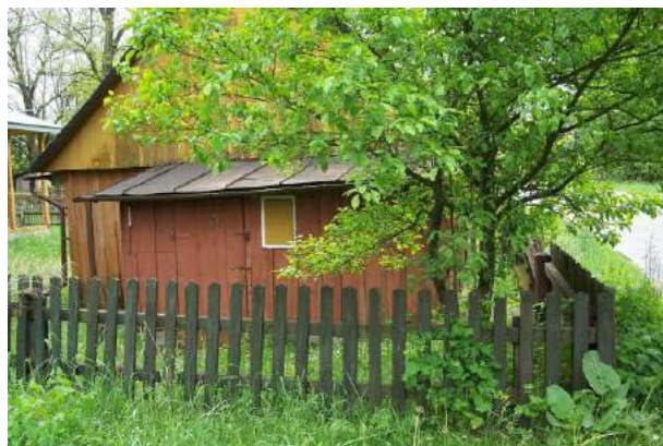
Fot.331. Znikły dachy kryte strzechą zastąpiła je blacha pozyskiwana z beczek
