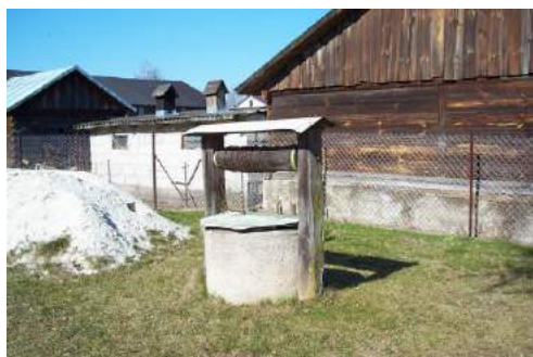
Fot.180. Studnia bardziej nowoczesna z kołowrotem z betonową cembrowiną też już dawno nie używana
