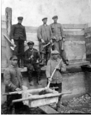
Fot.10. Robotnicy przy budowie kuchni
