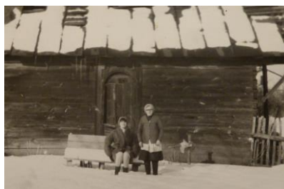
Fot.57. Kuźnia 1985 rok. Widok od strony domu mieszkalnego. Stoi Stanisława Radzikowska bratowa Piotra, ostatniego kowala
