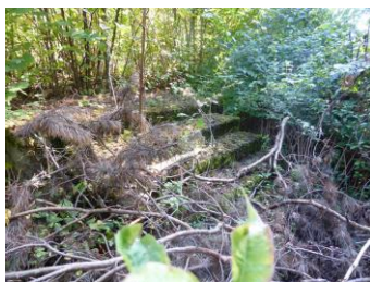
Fot.82. Tyle zostało z domu, który, kiedyś zamieszkiwali Kołtuniakowie
