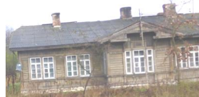
Fot.2. Może tak wyglądał dworzec? Ten budynek też ma pięć kominów i pochodzi z czasów carskich
