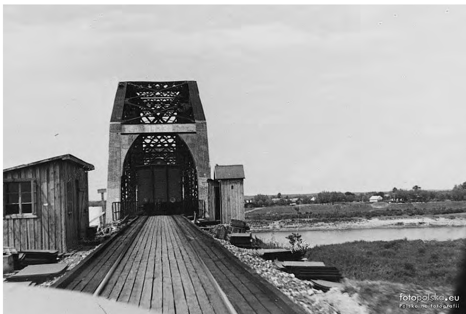
Il. 26. Most na Sanie w Kępie Rzeczyckiej wybudowany z ocalałych elementów mostu we Fronołowie.
