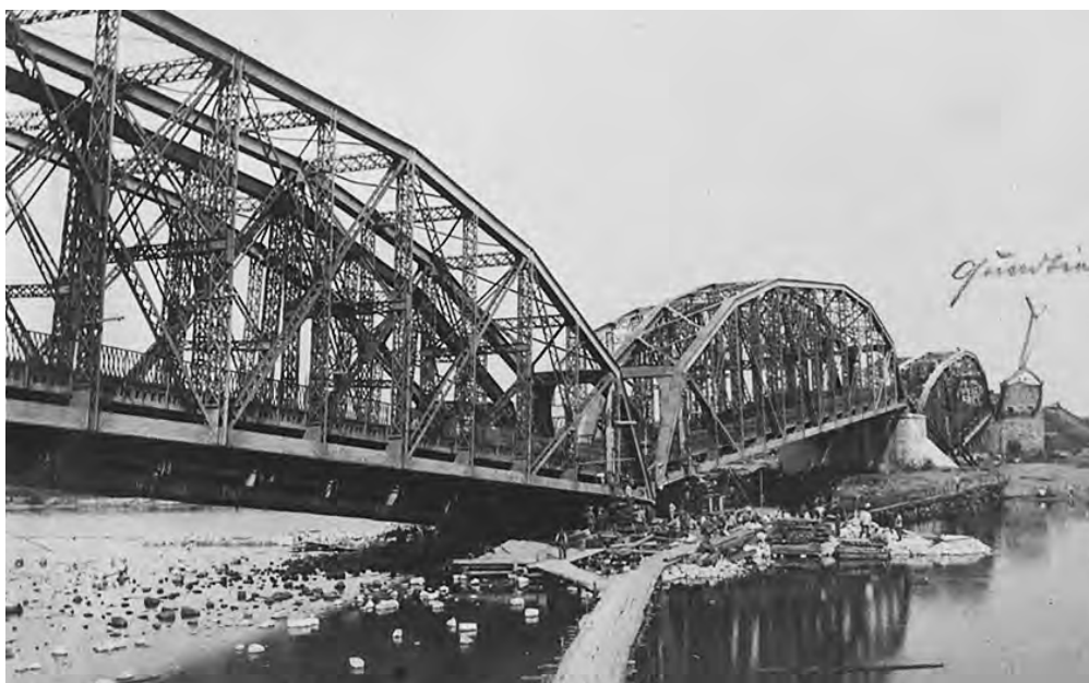
Il. 11. Most kolejowy na Bugu zniszczony przez wycofujące się wojska rosyjskie w 1915 r. Źródło: Zbiory Artura Soszyńskiego.
