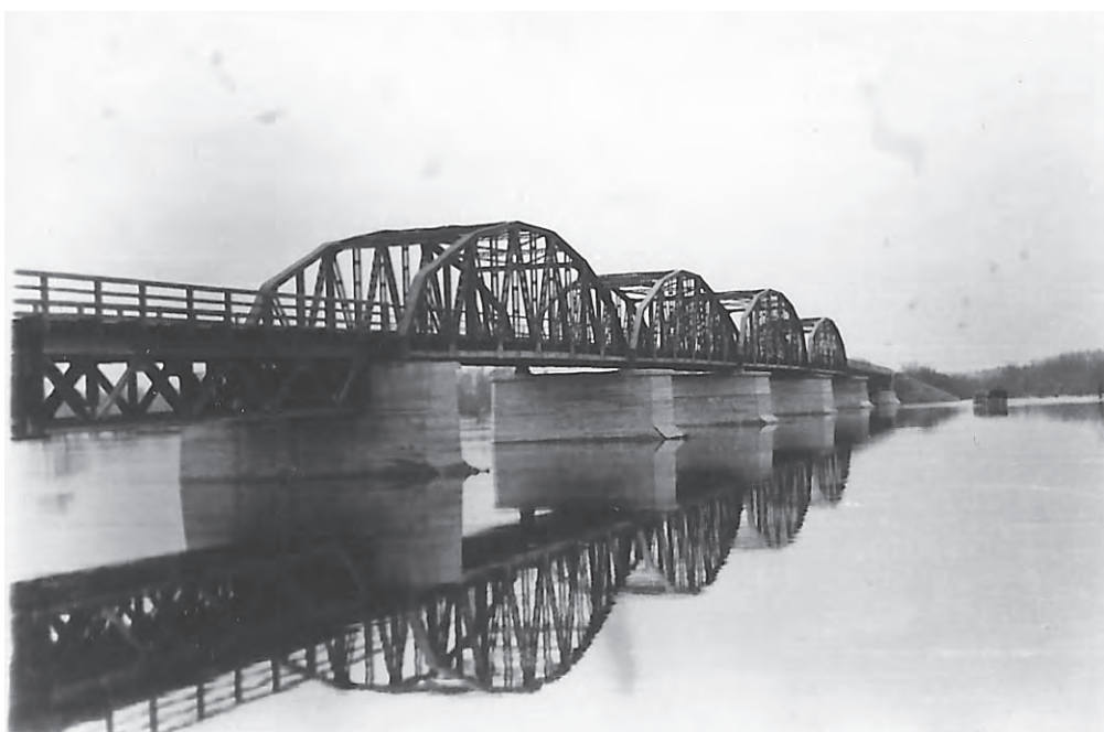
Fot. 5 i 6. Rok 1952, objazd otwartej trasy. Zdjęcia z kolekcji autora.
