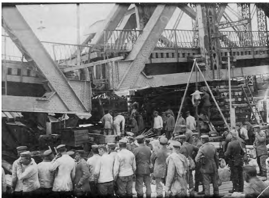
Il. 15. Prace remontowe przy moście na Bugu. Źródło: Zbiory Artura Soszyńskiego.
