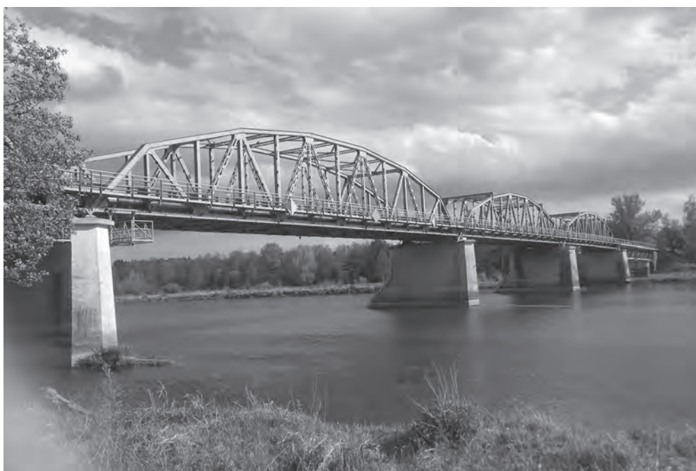
Fot. 11 i 12. Współczesne fotografie z widocznymi dobudowanymi filarami na przęsłach z jazdą górą. Fot. Tomasz Nasiłowski.
