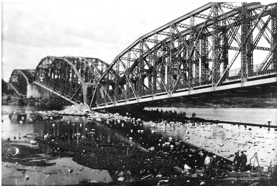
Il. 14. Most kolejowy na Bugu zniszczony przez wycofujące się wojska rosyjskie w 1915 r. Źródło: Zbiory Artura Soszyńskiego.
