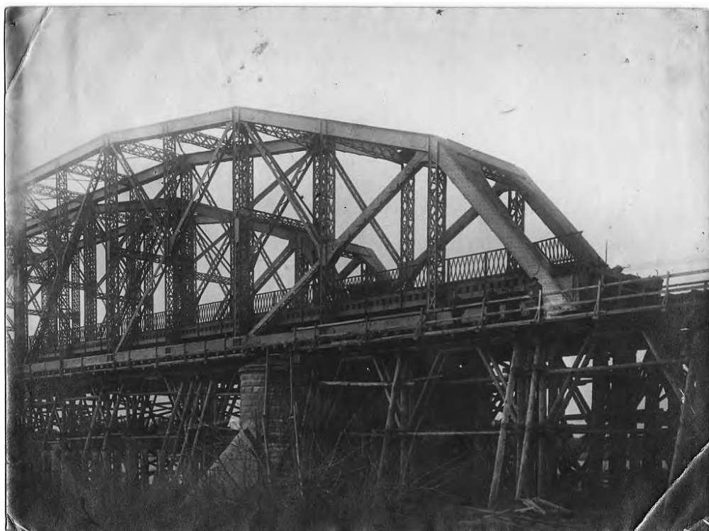
Il. 21. Przesunięcie przęsła mostu na Bugu 18 października 1920 r. Źródło: Zbiory Tomasza Nasiłowskiego.
