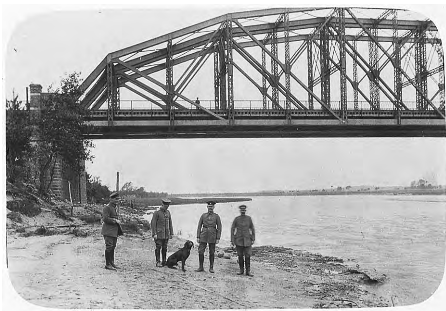
Il. 10. Most kolejowy na Bugu około 1915 r. Źródło: Zbiory Tomasza Nasiłowskiego.
