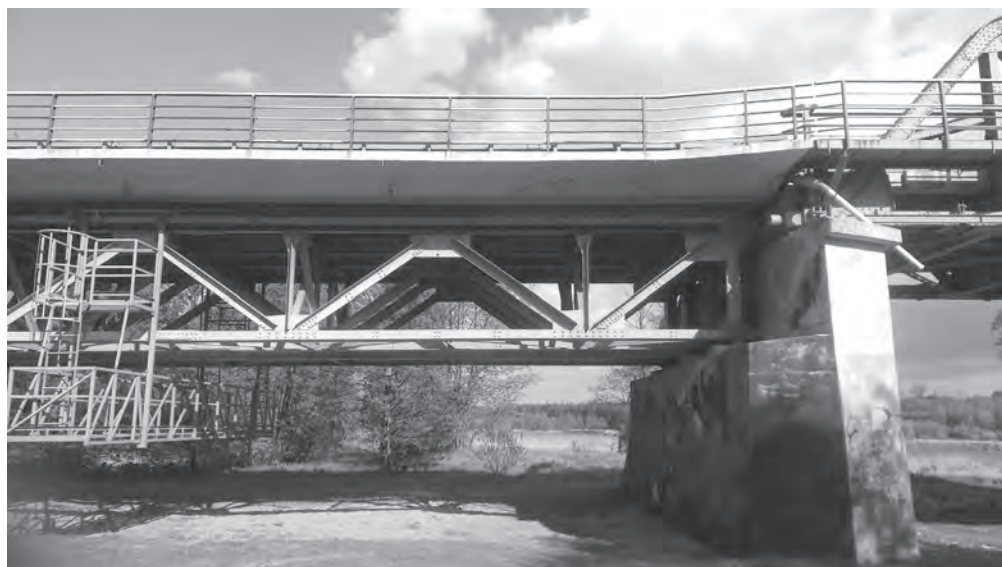
Fot. 1. Współczesna fotografia przedstawiająca przęsło z jazdą górą od strony Siemiatycz. Fot. Tomasz Nasiłowski.
