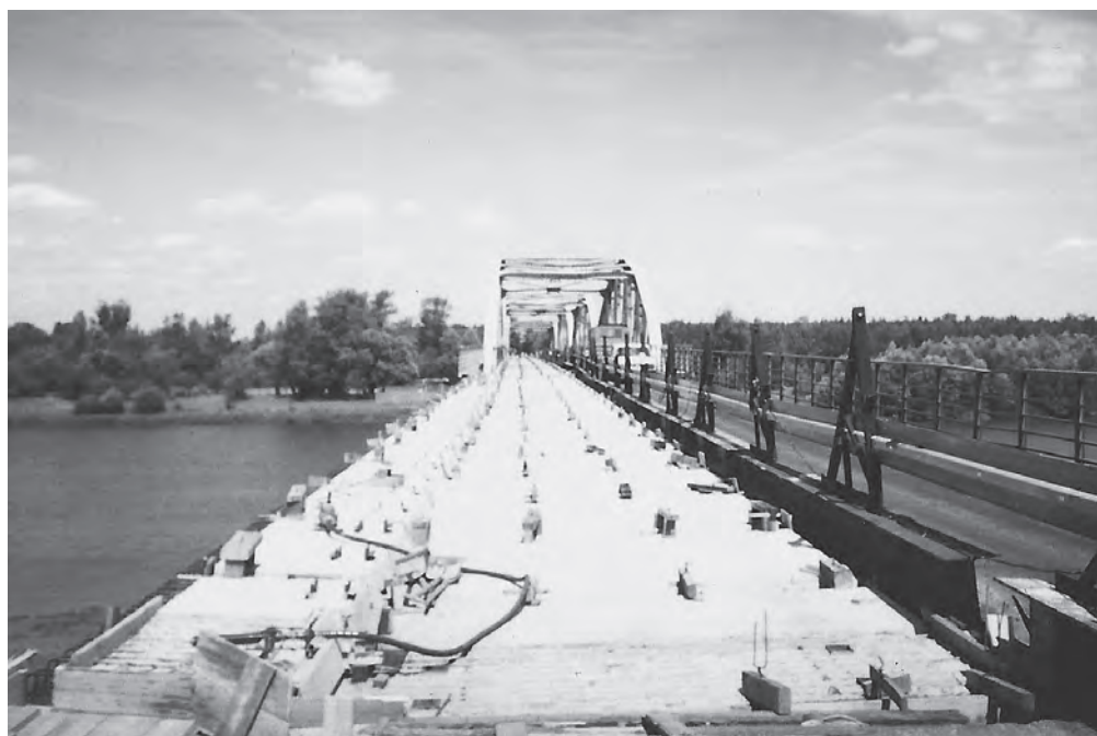
Fot. 8, 9 i 10. Fotografie z przebiegu prac remontowych w latach 1991-1994 udostępnione przez Powiatowy Zarząd Dróg w Siemiatyczach.
