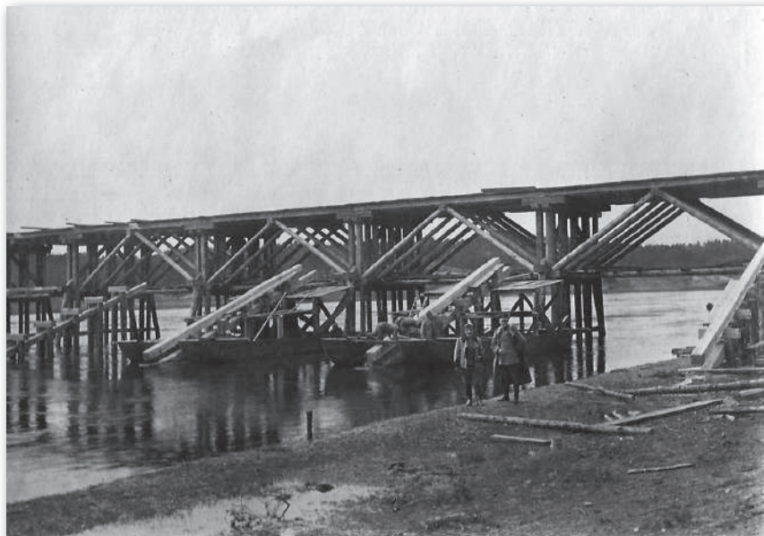
Most w Serpelicach wybudowany przez Niemców w czasie I wojny, który prawdopodobnie został zniszczony przez wycofujące się po klęsce w Bitwie Warszawskiej oddziały sowieckie. (Źródło: Kolekcja Tomasza Nasiłowskiego)
