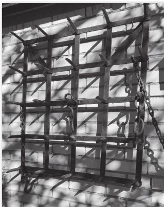
Brona konstrukcji kowalskiej
