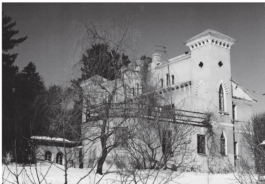
Fot. 4. i 5. Kasztel przed remontem i po remoncie, 1995 r.
